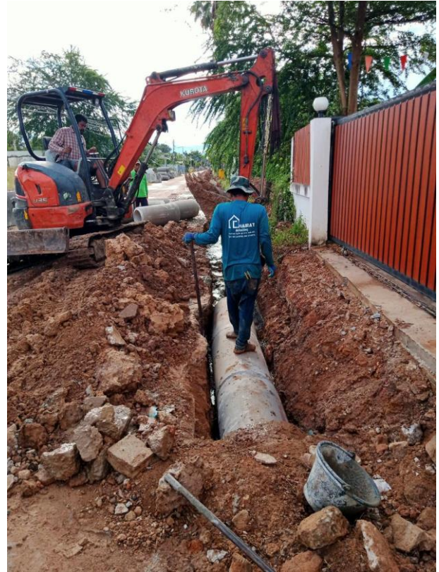
โครงการก่อสร้างวางท่อระบายน้ำคอนกรีตเสริมเหล็กพร้อมขยายผิวจราจรหมู่ที่ ๓ อำเภอห้วยเม็ก จังหวัดกาฬสินธุ์
